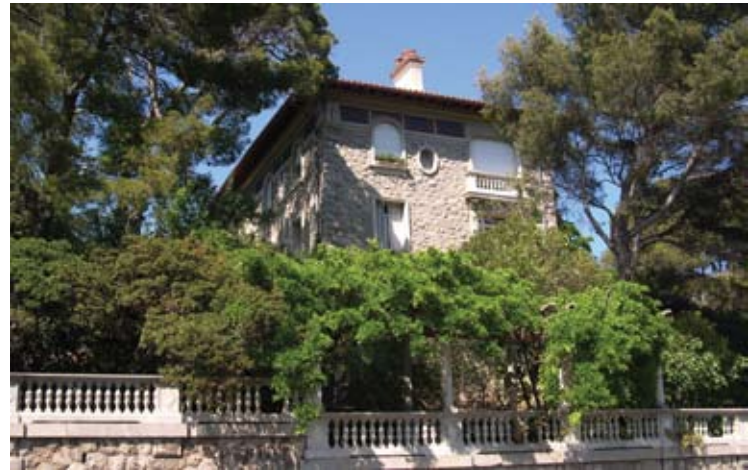
Le mur de clôture est construit dans le même appareil que la villa et surmonté de balustres en double poire.
